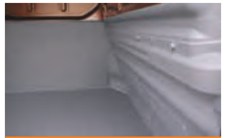
Vloer, wanden en kopschot vloeien ineen.
